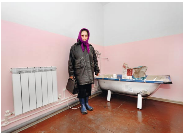
Das Haus ist nicht fertig: Venera Gaynetdinova soll bei Winterbeginn hier einziehen.
