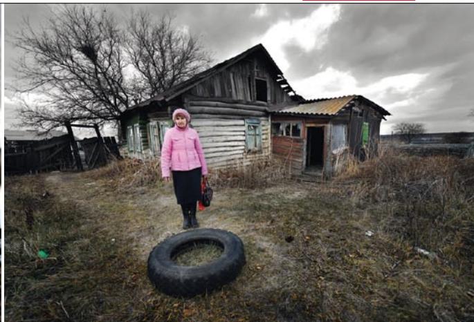
Bald dem Erdboden gleich: alte Wohnhäuser in Musljumovo
